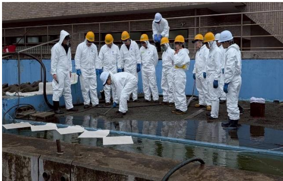
下游處挖溝防止污染，以吸油器吸除浮油，萬國旗鋪設吸油棉防止油污污染
